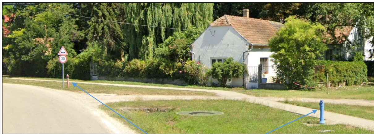
A 41/2 hrsz-ú telek Fő utcai csatlakozásánál lévő tűzcsap és közkifolyó /Forrás: KIRA Street View/
