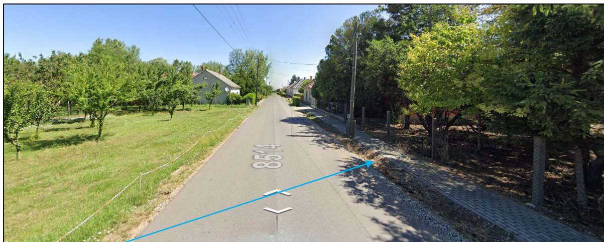
Meglévő árok a módosítás b.) pontjában lévő telekkel Rákóczi utcai szakaszán /Forrás: KIRA Street View/
